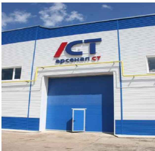
Вид на здание производства «Арсенал СТ»
